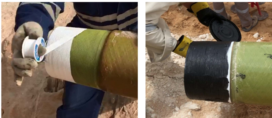
Figure 4. Handle the thread before installation 图 4. 安装前对外螺纹进行处理
