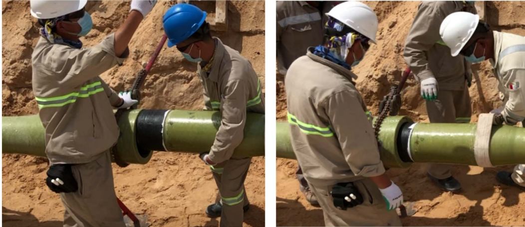
Figure 5. Manual installation pipe 图 5. 手动安装管道
