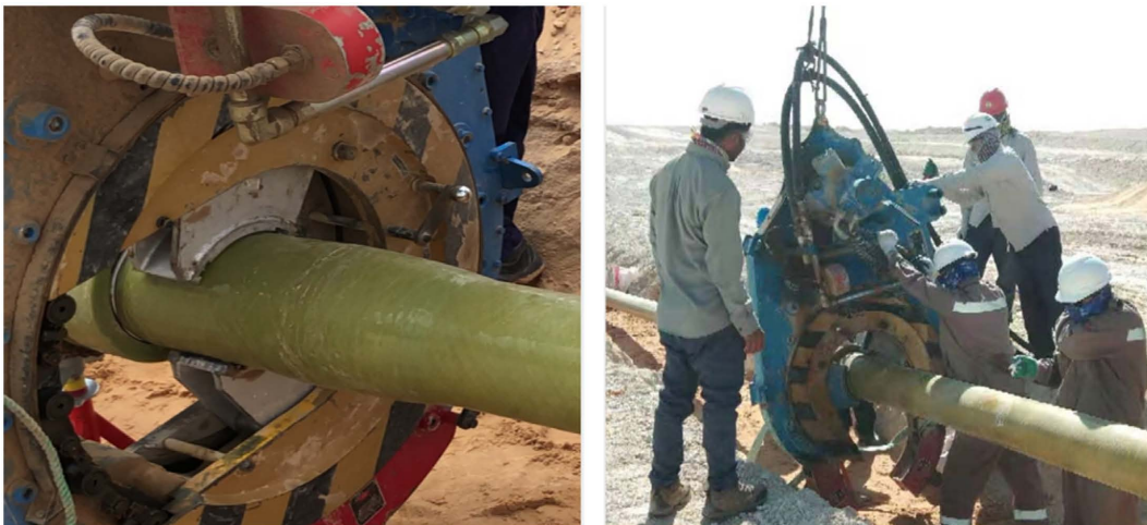
Figure 6. Hydraulic tong installation pipe 图 6. 液压钳安装管道
