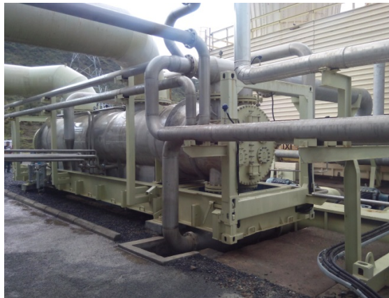
Figure 3. Surface condenser 图 3. 表面式冷凝器
