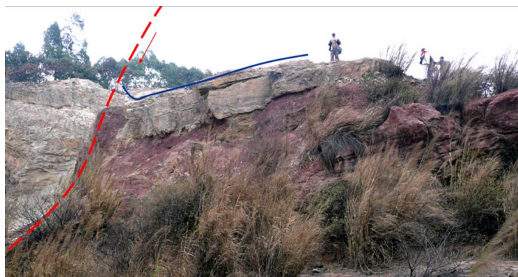
Figure 4. Drag in the NW fault 图 4. 北西向断裂及其下盘的牵引构造
