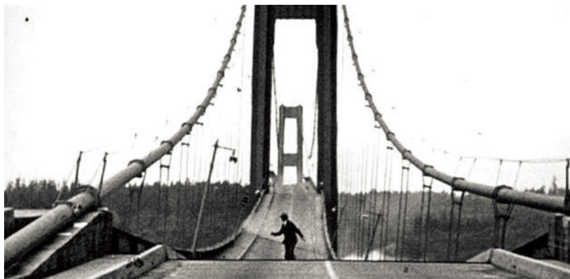
Figure 4. Tacoma Bridge accident 图 4. 塔克玛大桥事故
