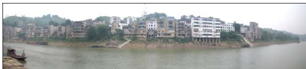
Figure 1. Rentuo landslide panorama 图 1. 仁沱滑坡全景
