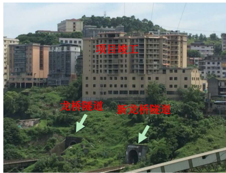
Figure 2. Project picture 图 2. 项目实景图
