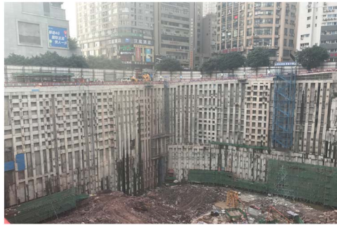
Figure 2. Reconstruction of the foundation pit 图 2. 重庆塔项目改建基坑
