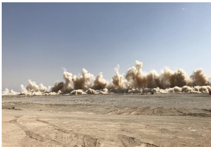
Figure 3. Blasting site 图 3. 爆破现场
