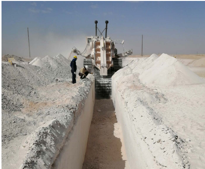
Figure 4. Chain trencher 图 4. 链式开沟机
