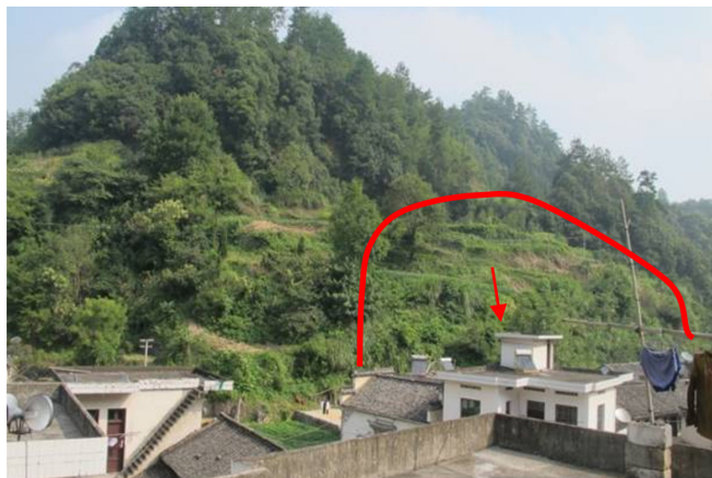
Figure 2. The whole Lin Chuan landslide 图 2. 林川滑坡
