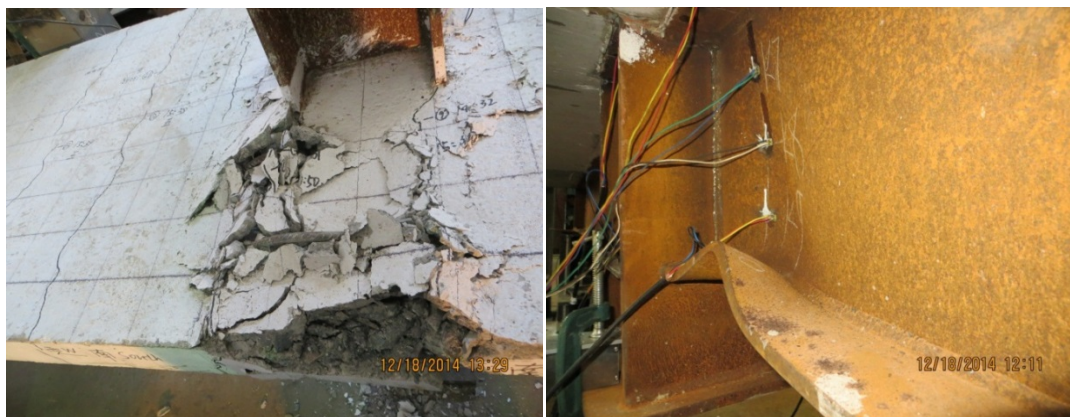
(a) 混凝土压溃, 试件破坏
