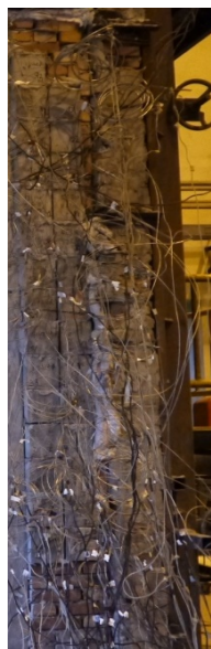
Figure 3. Unexposed side 图 3. 试验背火面
