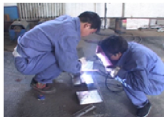
图1.3 用电焊机将已加工好的档板焊接 在两侧外框内侧
