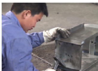
图1.8 用小锤将焊缝打磨平整
