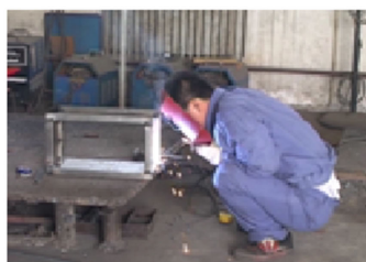
图1.7 调整电流后将外框缝隙满焊 防止漏风
