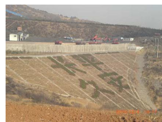
滑坡 HP4 (镜像西北)
