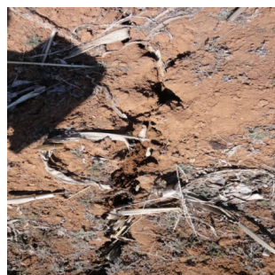
地裂缝 L1 (镜像东南)
