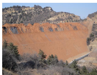
滑坡 HP3 (镜像西北)
