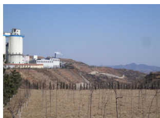
滑坡 HP1 (镜像西北)
