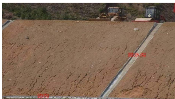
Figure 4. Drainage ditch 图 4. 排水沟
