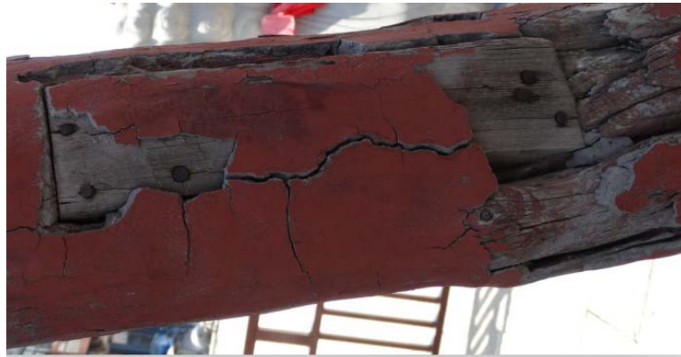
Figure 4. Repair method of replacement 图 4. 剔补的修复方法
