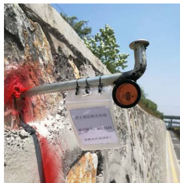
Figure 5. Monitoring points埋设现场图 图 5. 监测点埋设现场图
