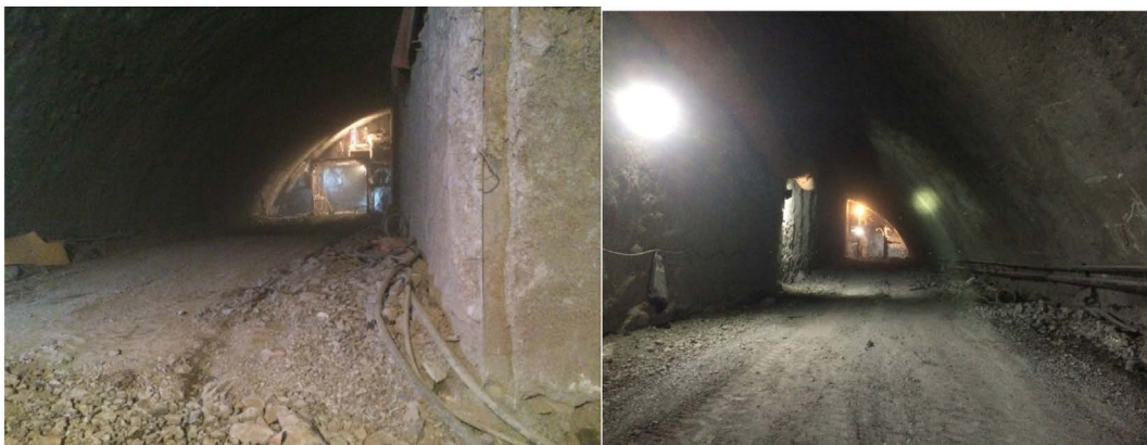
Figure 3. Station construction site photo 图 3. 车站施工现场照片
