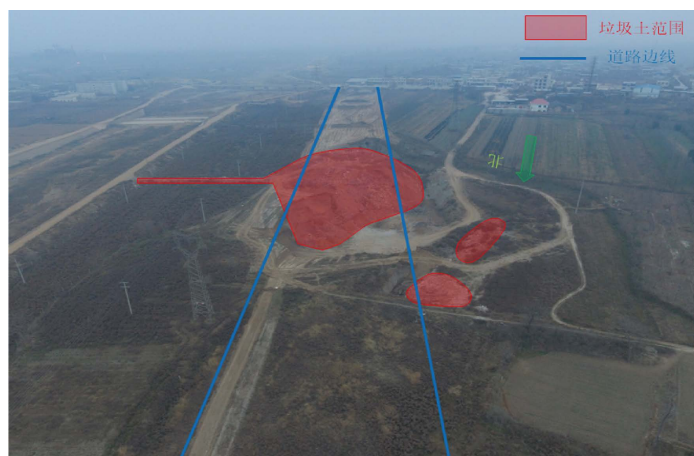
K30+700~K30+840垃圾坑航拍图
