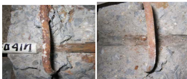
(a) 试块破型后锈蚀情况
