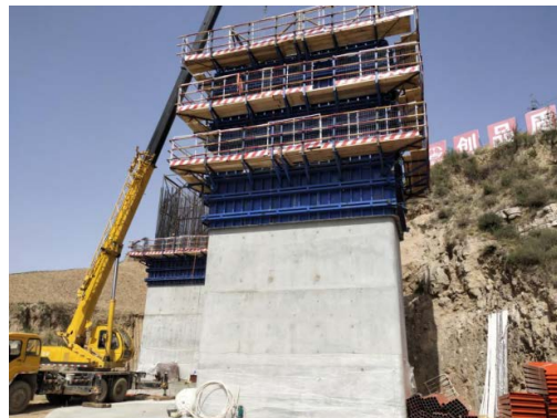
Figure 4. Construction work platform 图 4. 施工作业平台
