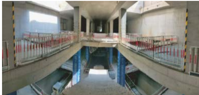
Figure 14. The Xinfadi Station of the 19 th line of Beijing subway 图 14. 北京地铁 19 号线新发地站
