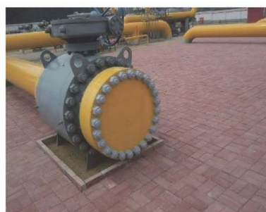
(b) 压气站法兰螺栓及法兰缝防腐修复
