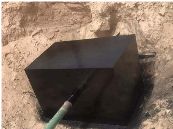
Figure 17. Concrete coating 图 17. 混凝土防腐
