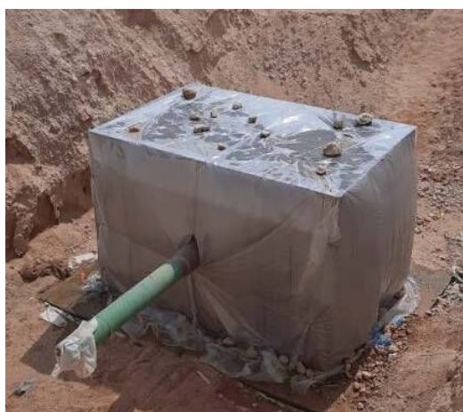
Figure 16. Curing 图 16. 养护
