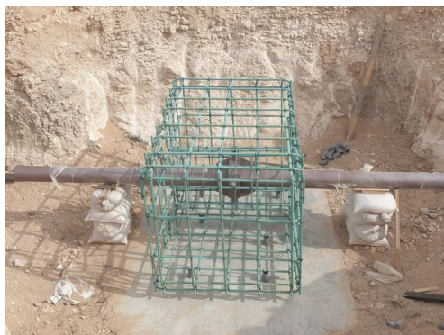
Figure 12. Rebar binding 图 12. 钢筋绑扎
