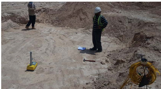
Figure 19. Compaction test 图 19. 压实试验
