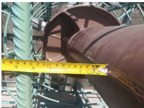
Figure 13. Clearance inspection 图 13. 间距检查
