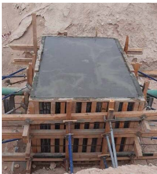
Figure 15. Concrete pouring 图 15. 混凝土浇筑
