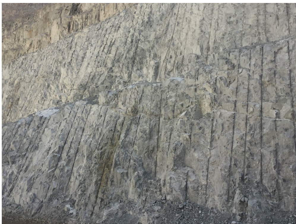
Figure 1. Rendering of pre-split blasting 图 1. 预裂爆破效果图
