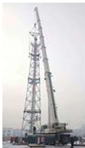
Figure 17. Result of the integral hoisting 图 17. 整体吊装完成
