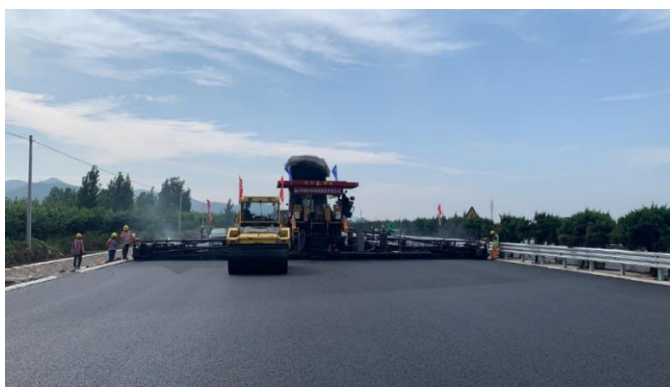
Figure 3. Full-scale seamless construction site map 图 3. 全幅无缝施工现场图
