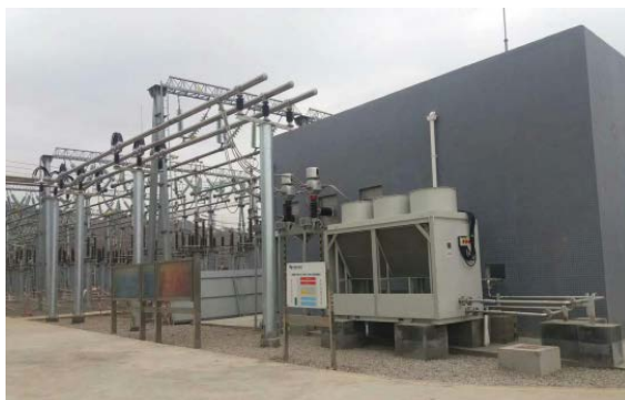
Figure 7. DC ice melting device 图7. 直流融冰装置
