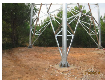
Figure 6. Basic plane of triangular tower 图 6. 三角塔基础平面
