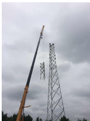
Figure 7. Triangular tower installation 图 7. 三角塔吊装施工
