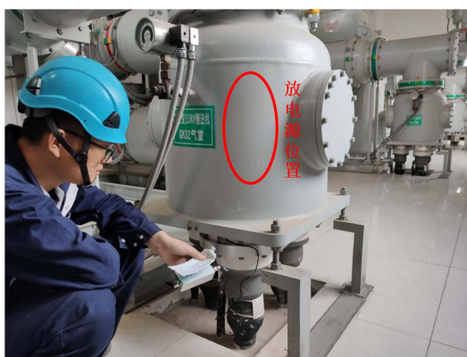
Figure 13. Photo of the location of the discharge source 图 13. 放电源位置照片
