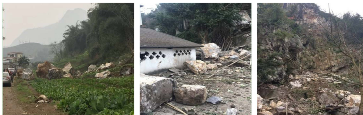
(a) 中坝村 4 组崩塌
