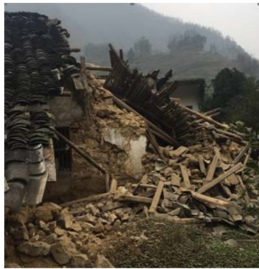
(a) 乐义乡黄金村砖木结构房屋倒塌
