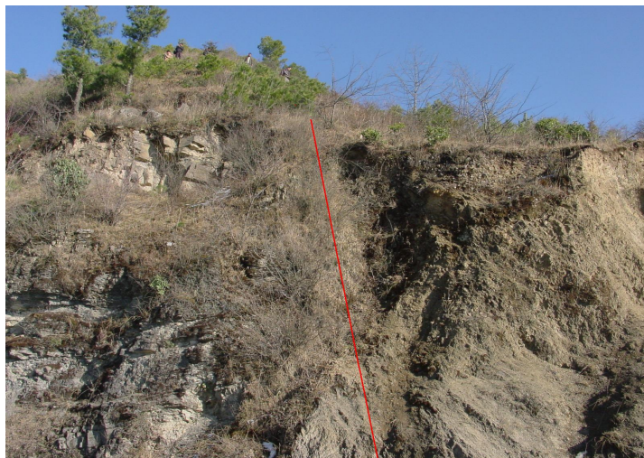
Figure 7. The picture of breakage fracture zone 图 7. 断裂面位置图
