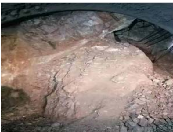
Figure 6. Palm face photos of 11 + 78 图 6. 1 斜 11 + 78 掌子面照片
