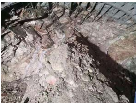
Figure 5. Palm face photos of 11 + 88 图 5. 1 斜 11 + 88 掌子面照片
