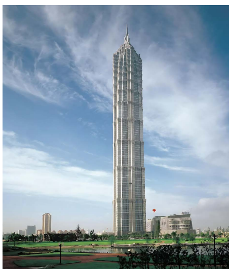
Figure 2. Real picture of Shanghai Jinmao Tower 图 2. 上海金茂大厦实景图 ②
