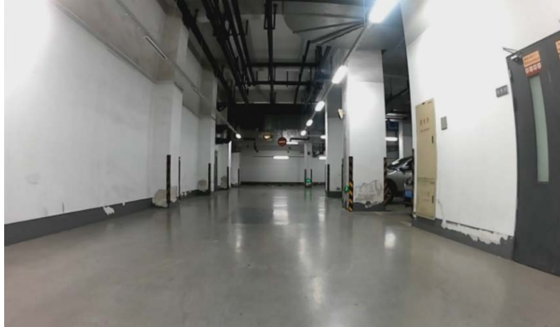
Figure 9. Representative image of the underground parking 图 9. 地下停车场的代表图像
