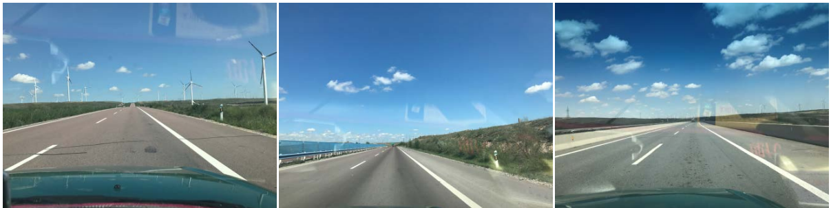
Figure 2. Test section site map 图 2. 试验路段现场图
