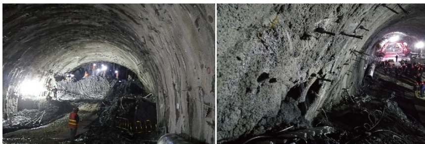
Figure 2. Local intrusion limit 图 2. 局部侵限图
