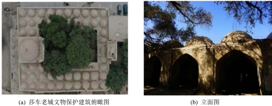
Figure 1. Dome pictures 图 1. 穹顶照片
