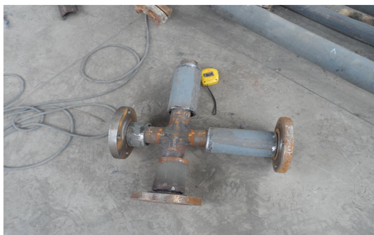
Figure 7. Jacket pipe under construction 图 7. 正在施工制作的夹套管道
