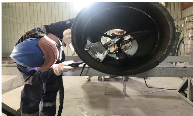
Figure 6. Picture of new blocking method 图 6. 新型封堵方式
