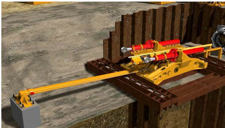
Figure 10. Installation of the antiroll unit 图 10. 防翻转装置安装
