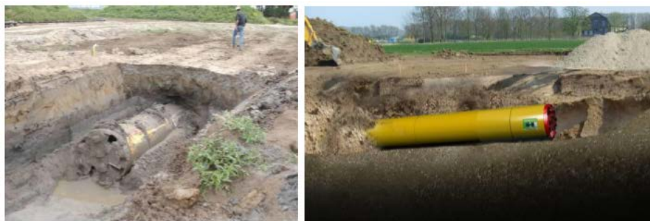
Figure 17. Thrusting unit reach the exit pit 图 17. 掘进机到达出土点
