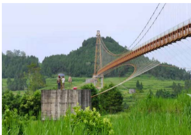
Figure 7. Linear measurement of main cable 图 7. 主索线性测量
