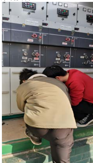
(b) System installation process (b) 系统安装过程
