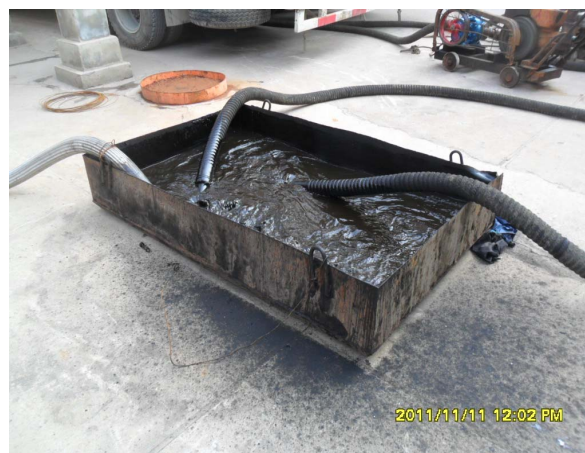
Figure 9. The Two Distillation desalting the backwash mode 图 9. 二蒸馏电脱盐目前反冲洗方式
