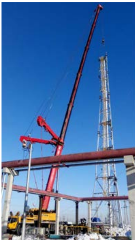
Figure 16. Result of the integral hoisting 图 16. 整体吊装过程
