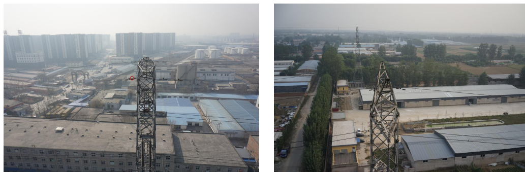
并钩线夹处导线头未绑扎塔头锈蚀
