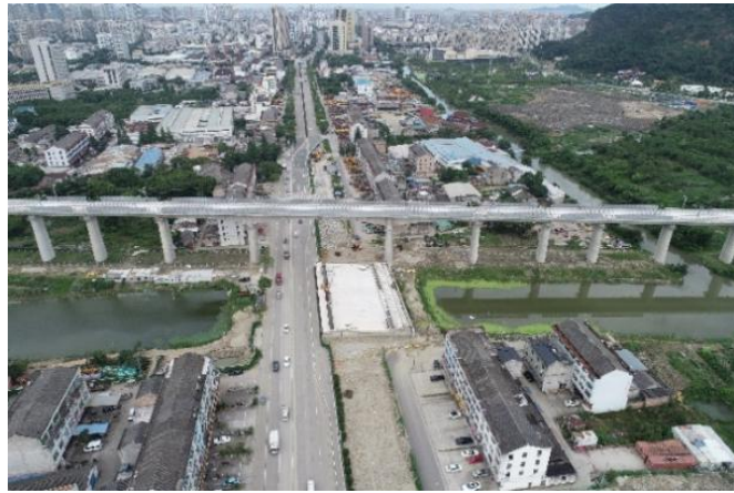
Figure 1. Site photos before project adjustment 图 1. 工程方案调整前的现场照片
